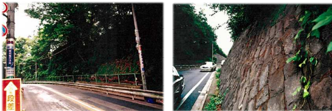
道路防災総点検箇所の例
