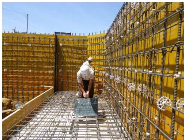
開発行為に伴う擁壁築造現場の配筋検査
