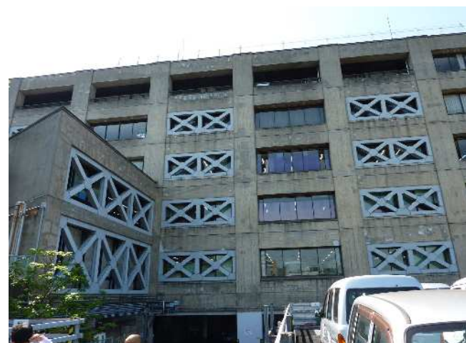
第2庁舎 耐震補強
