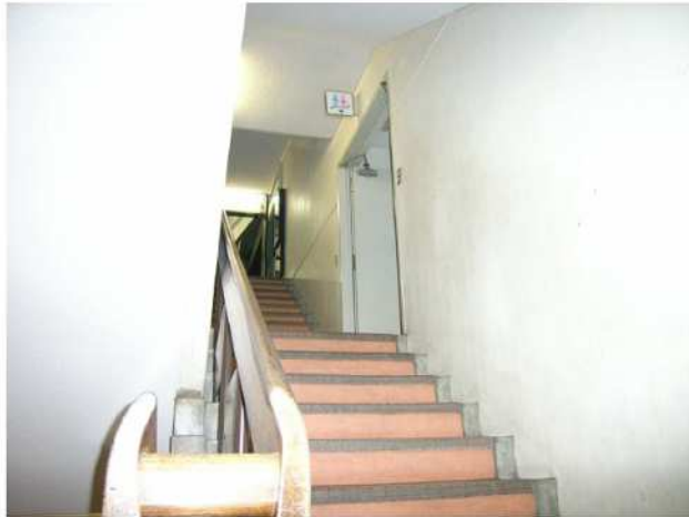
階段の途中のトイレ(第1庁舎)
