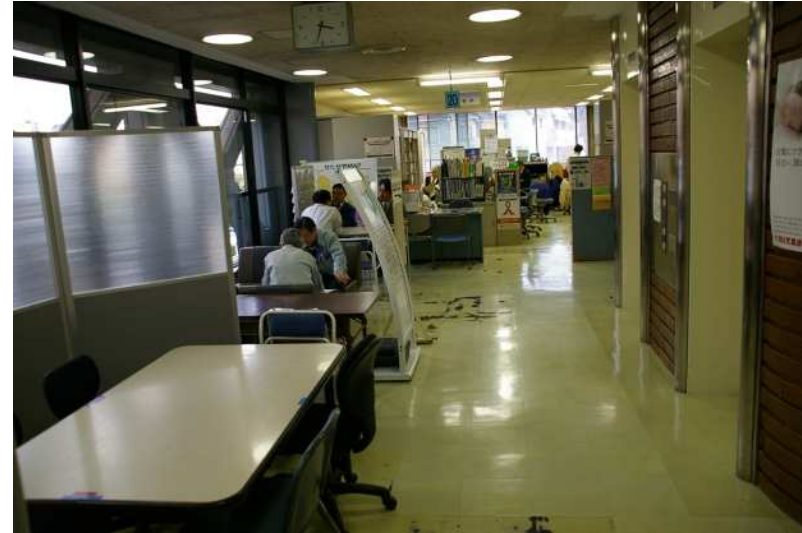
エレベーターホールを打合せスペースに転用
