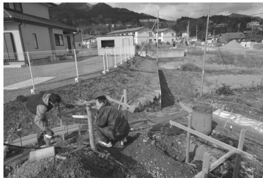
(写真6) 食堂営業のためのキッチンの建設
