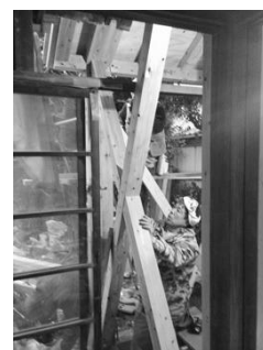
写真3 耐震補強工事
