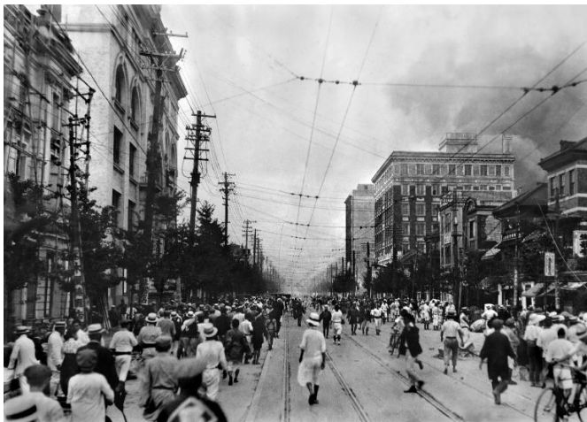
地震発生直後の日本橋室町 (東京都復興記念館所蔵)
