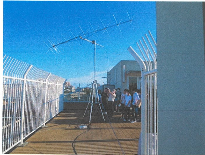
『烏山北小学校屋上に設置した交信用アンテナ』
