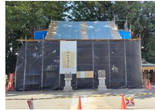
▲今年には社殿改修中
