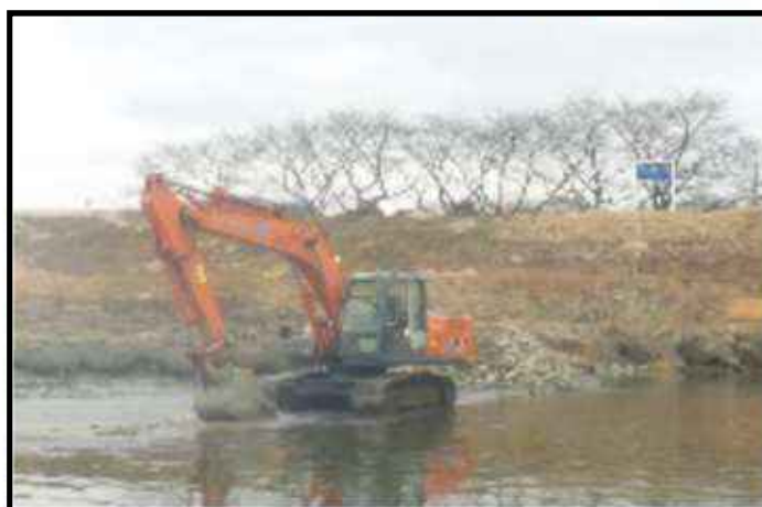
河道内の土砂掘削事例
