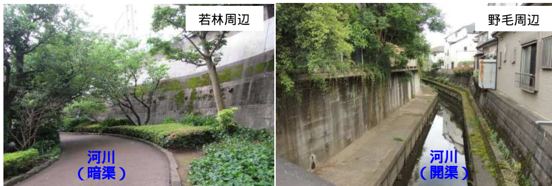
河川の侵食による地形の例
