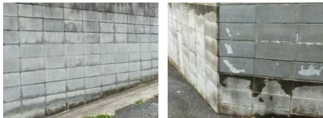
コンクリートブロック積擁壁
