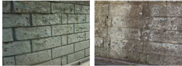
大谷石積擁壁
