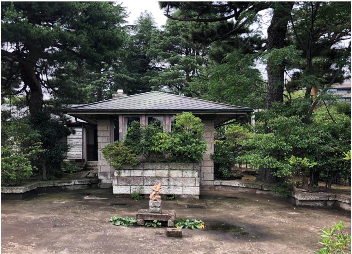
写真2 旧林愛作邸 徒渉池からみる大広間外観
