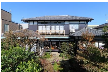
主屋南側外観
