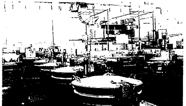
調理室：手前が回転釜、奥が連続炊飯機で一日約2,500食以内を目処にお米を炊いています。
