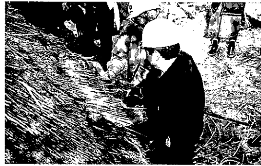
写真2 ツチで屋根面をたたく (平成12年度民家園で行われた茅葺き見学会&体験会)
