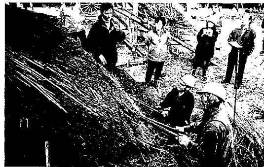
写真3 鉋で刈る (平成12年度民家園で行われた茅葺き見学会&体験会)
