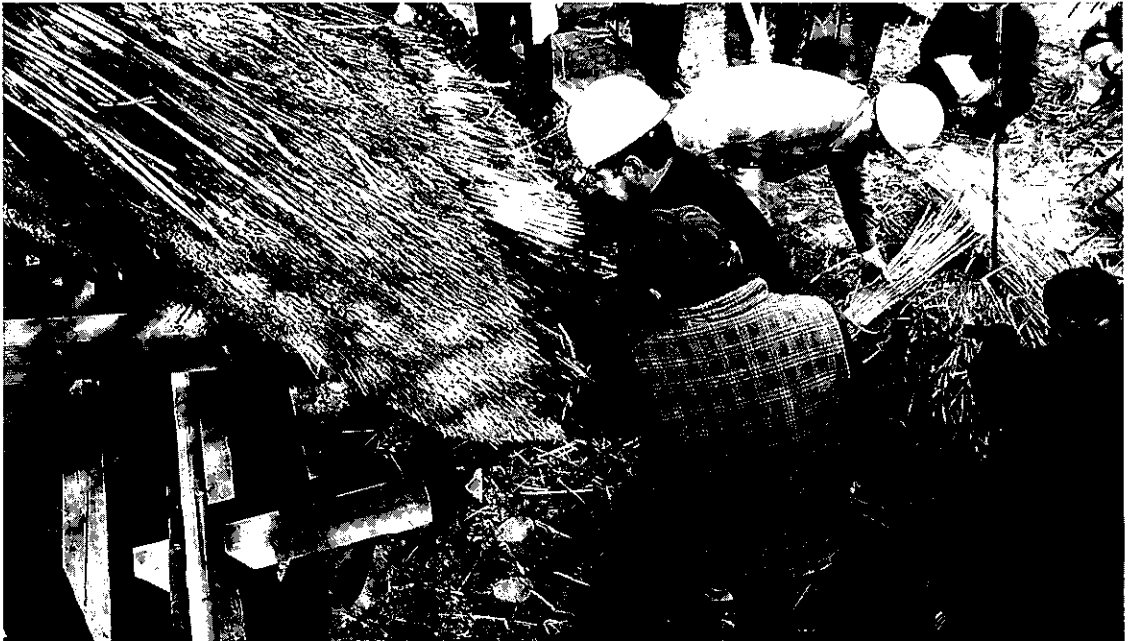
写真1 新しい茅を差し込む (平成12年度民家園で行われた茅葺き見学会&体験会)
