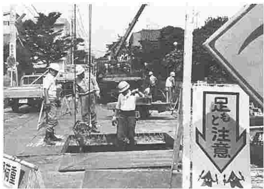
着々と進む下水道工事（鳥山幹線宮坂一丁目付近）。
