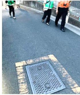
路上の消火栓
