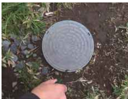
マイナスドライバーで汚水ますを開ける 中の様子
