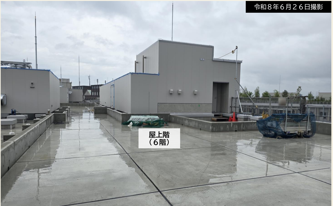
西棟屋上の様子。植栽や太陽光パネル設置は、3期工事で行います。
