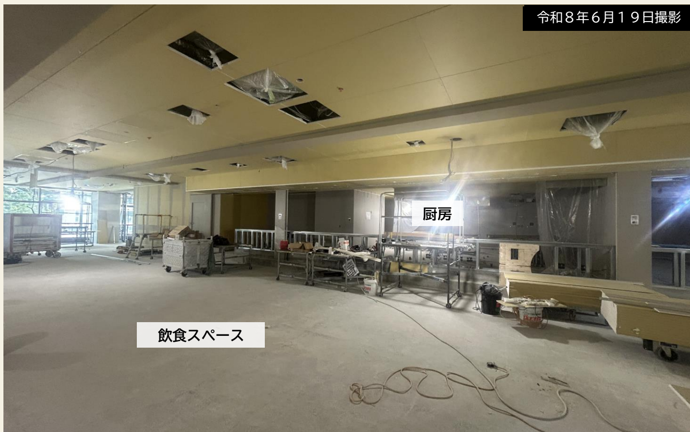
2階カフェ・レストランの様子。10月下旬のオープンに向けて、内装仕上げ作業を進めています。
