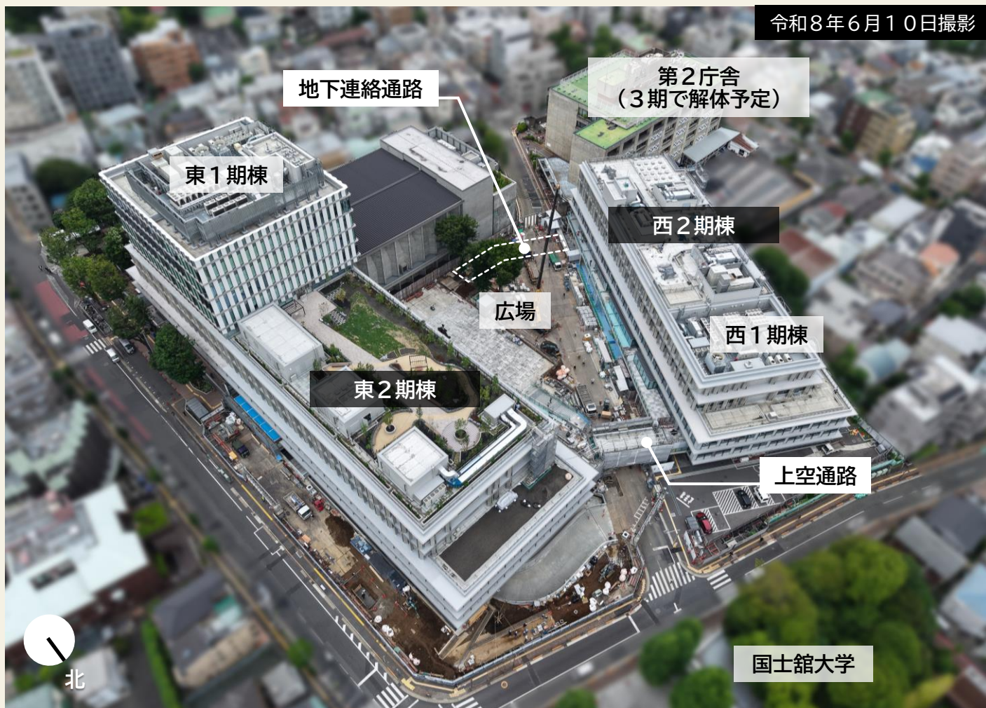
北側（国土館大学側）より、工事敷地全体の状況を撮影
