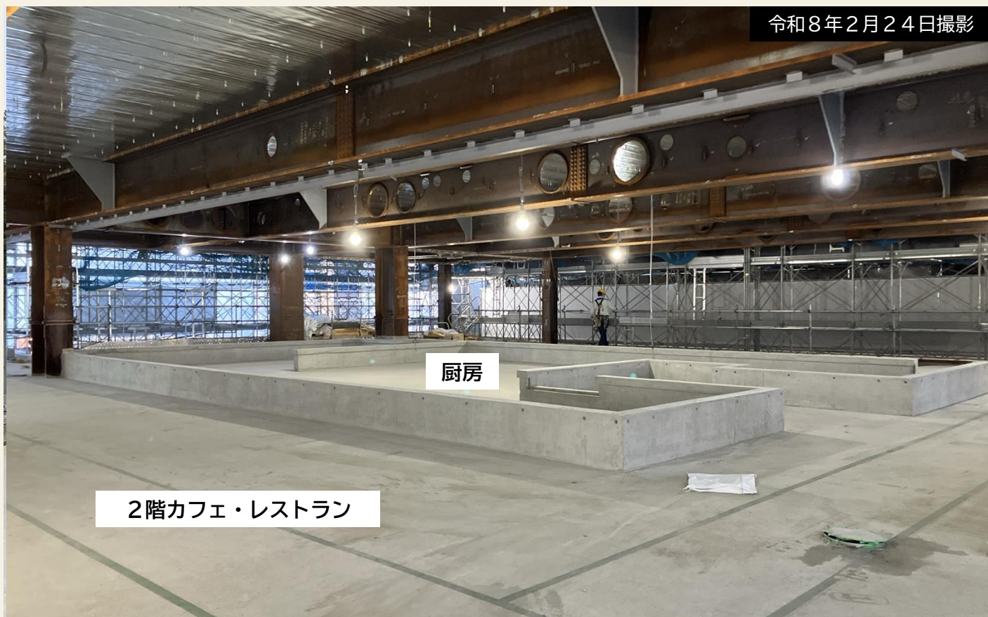
2階カフェ・レストラン付近の様子。コンクリートで囲われている部分は厨房になります。
