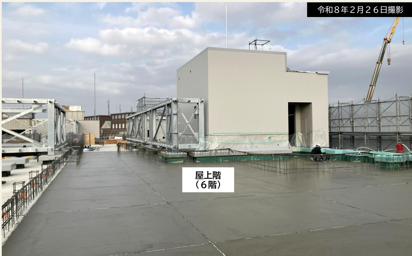
屋上の様子。アスファルト防水を施した上に保護コンクリートを打設しています。
