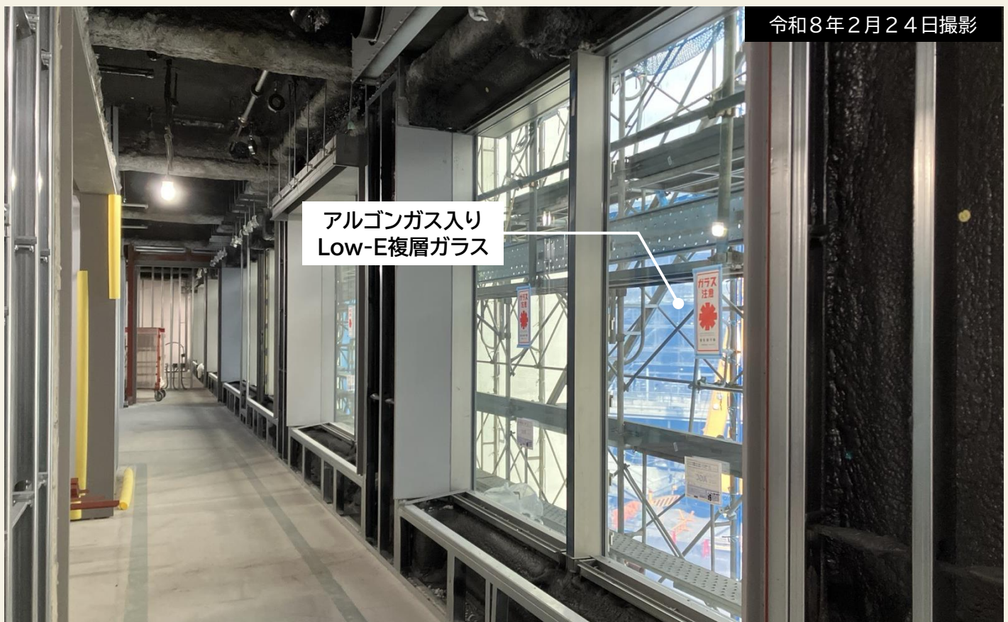
3階廊下の様子。サッシと断熱性に優れたアルゴンガス入りLow-E複層ガラスの取付けが完了しました。
