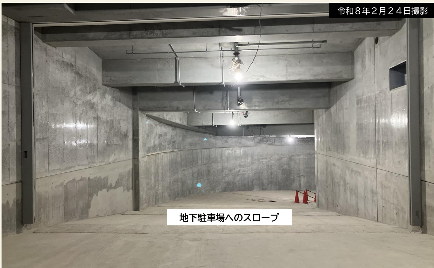
地下駐車場へのスロープの様子。今後、床面には、高強度で耐摩耗性のある「真空コンクリート」を打設します。
