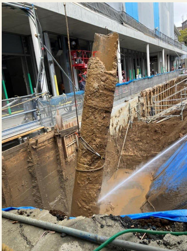
旧第3庁舎の基礎杭は全て引き抜き、撤去しました。
