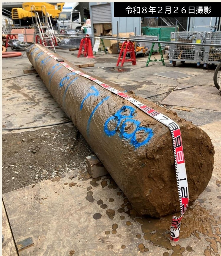
旧第3庁舎の基礎杭は全て引き抜き、撤去しました。
