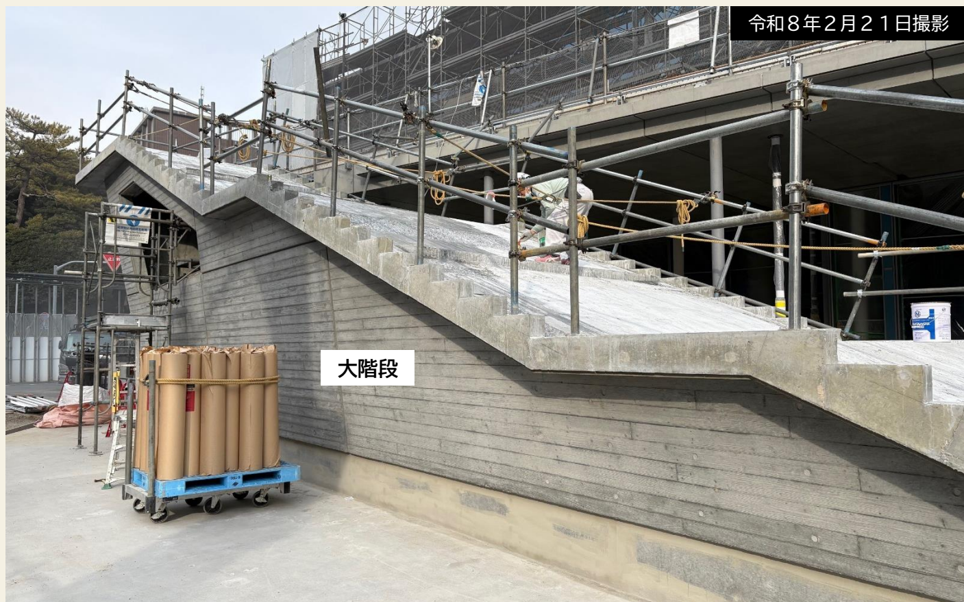
広場の大階段の様子。階段の側面は杉板型枠を使用し、特徴的なデザインとしています。
