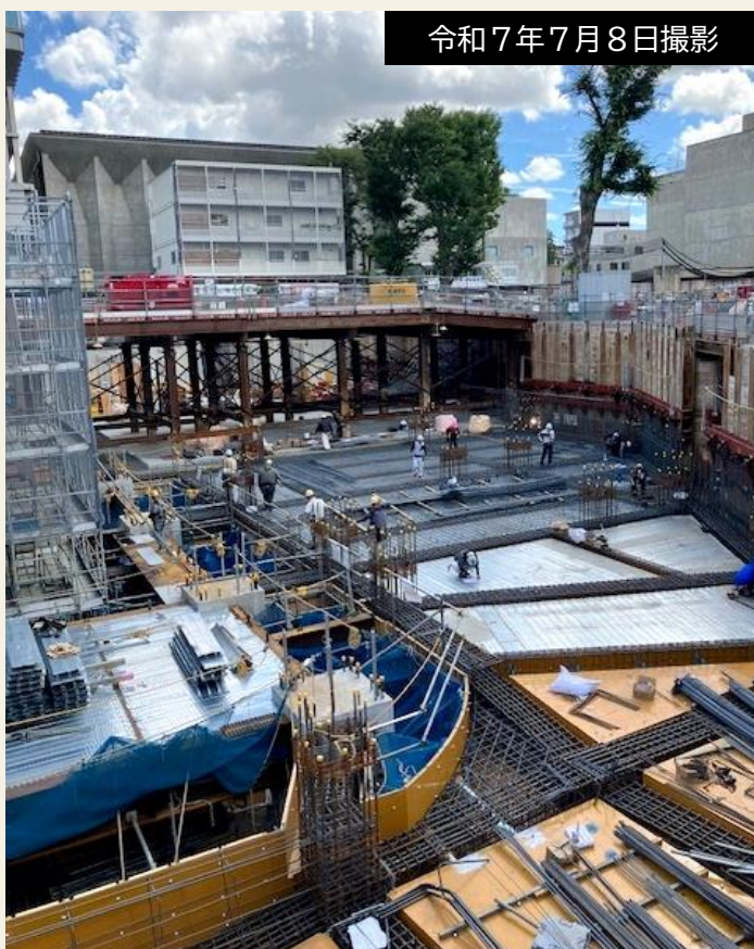
スロープ廻りの様子。傾斜のあるスロープ部分は、大工職人がコンパネ(オレンジ色の部材)で型枠を組み立てています。
