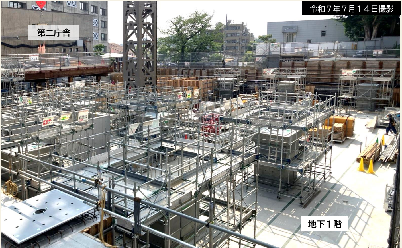
西1期棟側から見た敷地の様子。柱の廻りに足場を組み、免震装置を取り付ける準備をしています。
