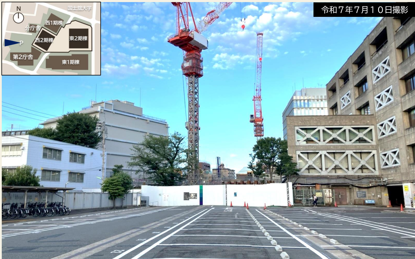
西側(第二庁舎地下駐車場)から撮影
