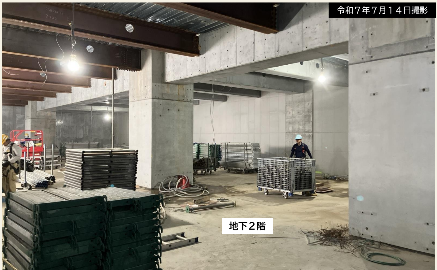
地下2階の様子。躯体工事が完了し、屋内の空間が出来上がりました。現在、内壁の工事を行っています。
