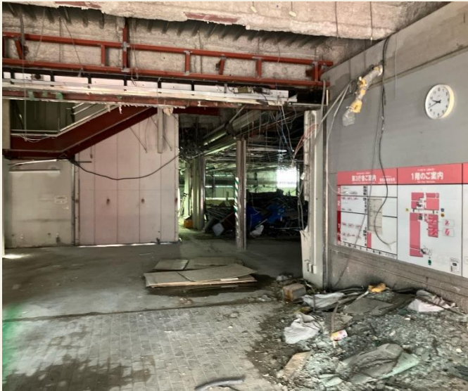
エントランス(左)・ピロティ(右)。躯体の解体に先立ち、外装や内装の解体を行いました。
