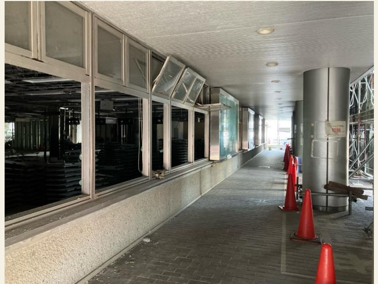
エントランス(左)・ピロティ(右)。躯体の解体に先立ち、外装や内装の解体を行いました。
