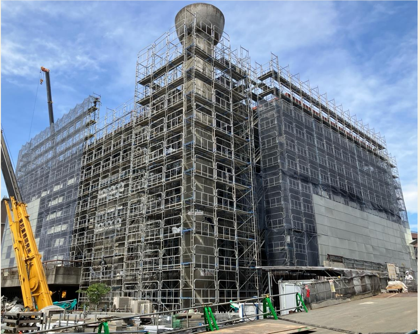
建物より高い位置まで防音パネルを組み、周囲への解体時の騒音を低減します。
