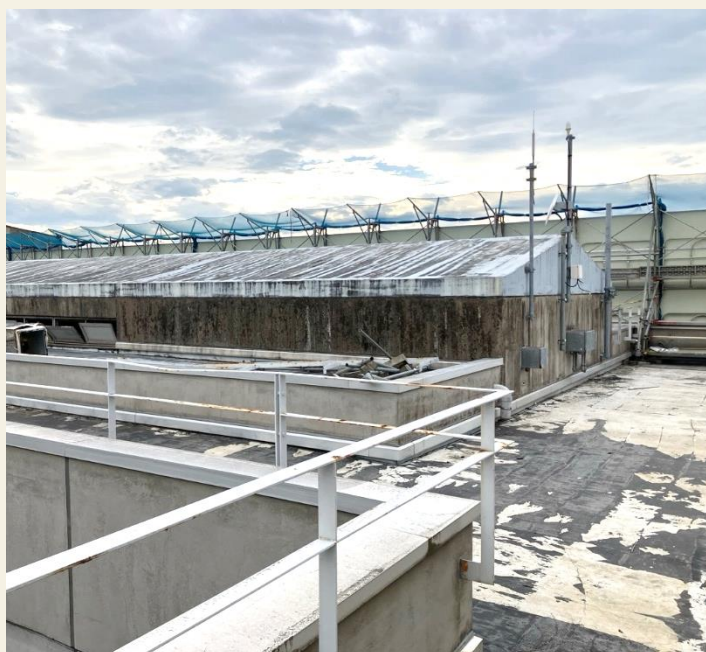
屋上では、敷設されていた防水層を撤去しました。三角の屋根(写真右)はブライトホールの上部です。
