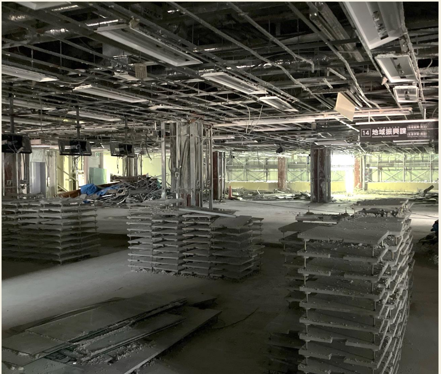
区民窓口があった1階では、分別回収のため、先行して床材(OAフロア)を撤去しました。
