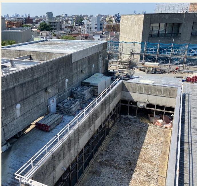
屋上では、敷設されていた防水層を撤去しました。三角の屋根(写真右)はブライトホールの上部です。
