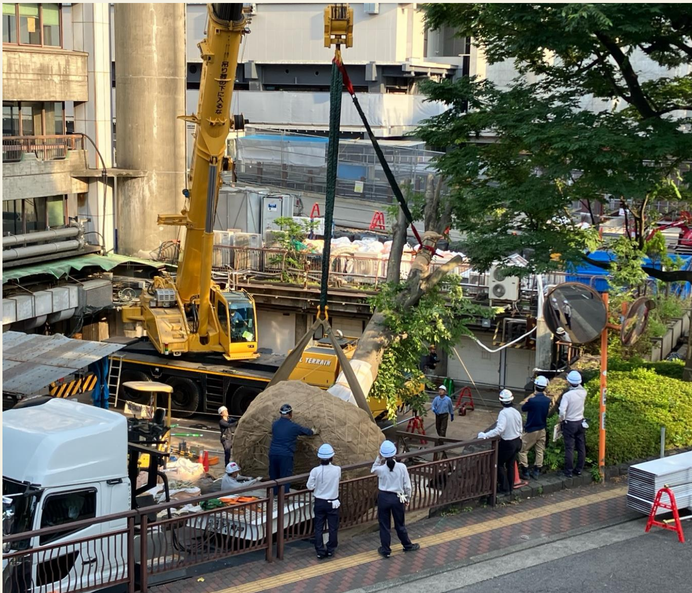
中庭にあった既存樹木(けやき)を、一時的に場外移植しました。2期完成時には、再度、新庁舎敷地内に移植します。
