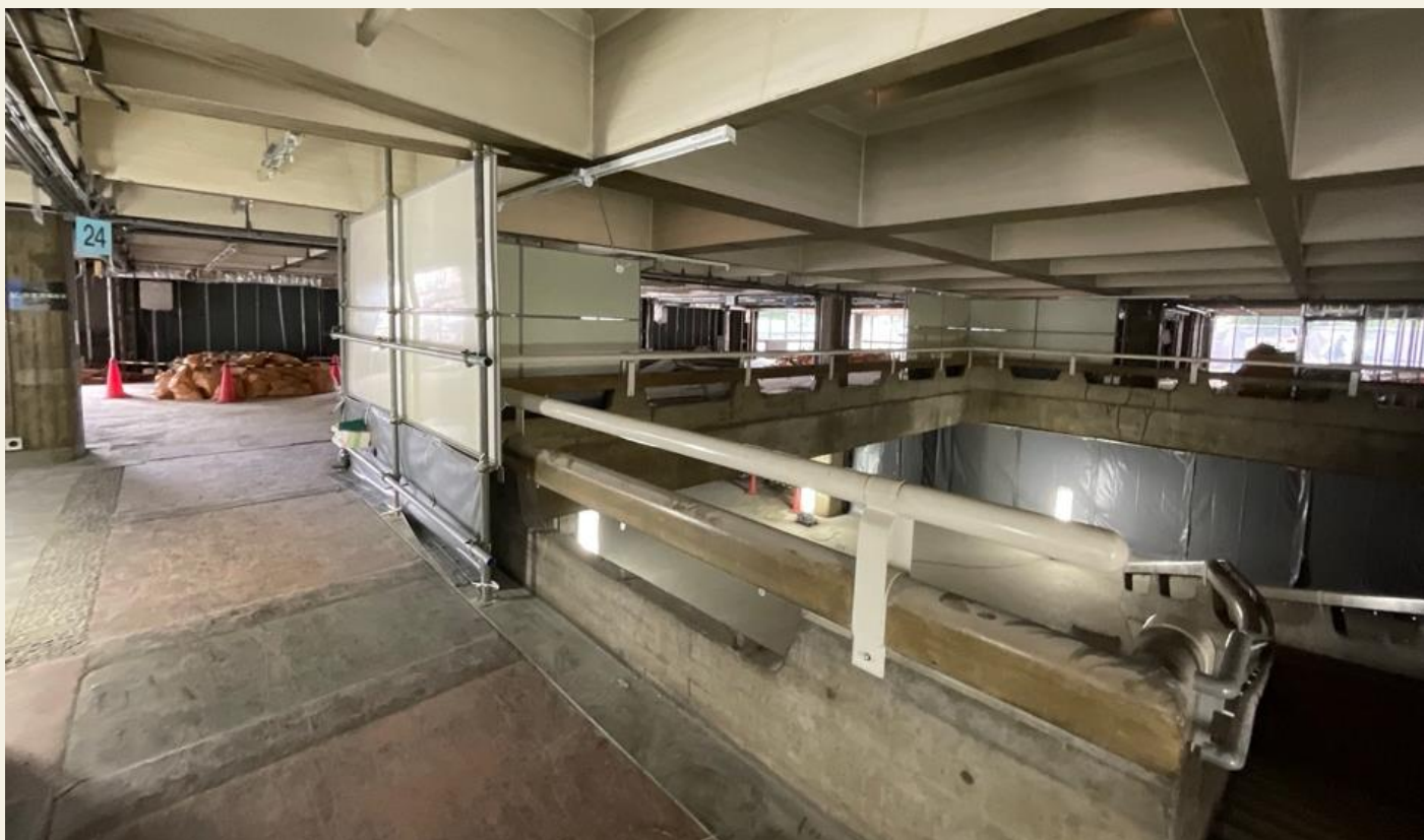
2階吹き抜けまわりの廊下
