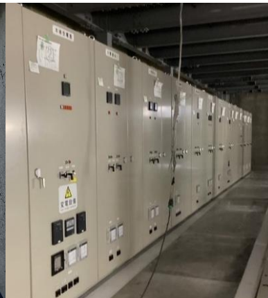
③地下1階 電気室に据え付け
