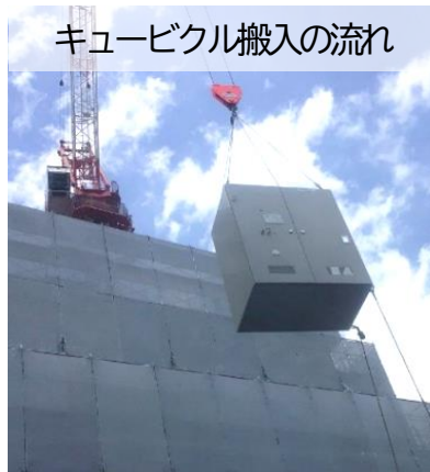
① クレーンで吊り上げ
