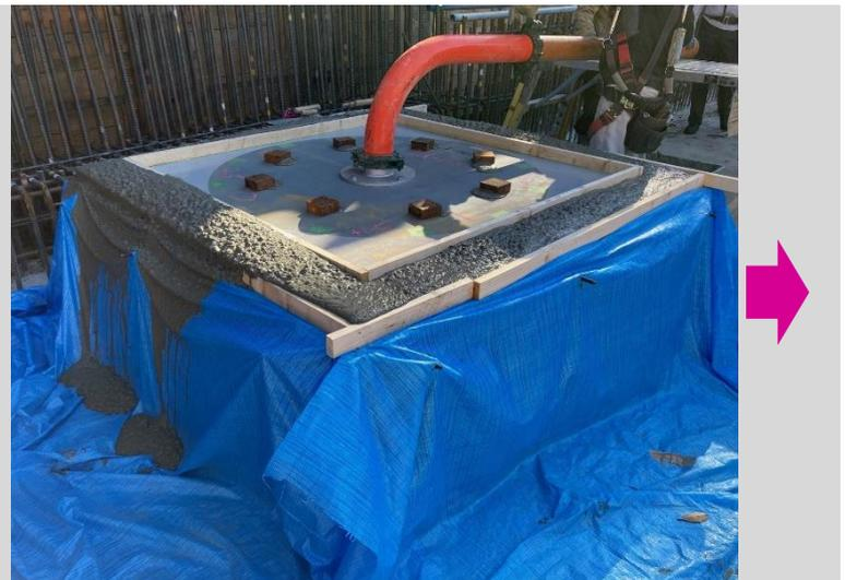
上の写真は、免震装置を取り付ける基礎を作っている様子です。免震装置を設置する底板を組み込んだ型枠に、高流動コンクリートを、折れ曲がった片長バンド管を使用して、上部からゆっくり流し込むことで、均一にムラなく打設することができます。右上は、打設完了直後の様子です。一定時間経過後、周囲の余分なコンクリートを除去し、基礎の形を整えます。
