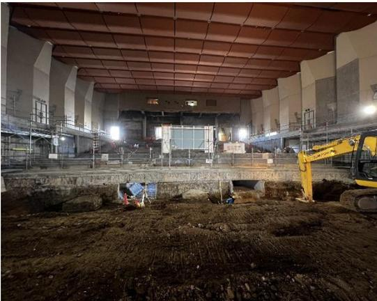
新しい区民会館には、昇降式の前舞台を設置するため、客席前面の床の掘削作業を進めています。(左の写真)
