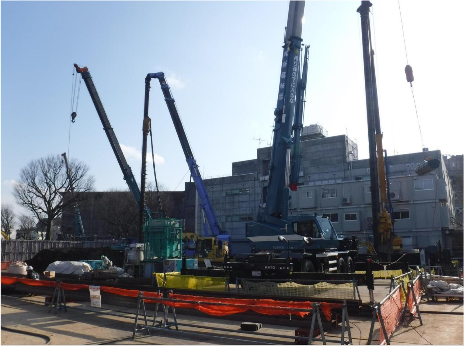
西敷地は、既存建物(第三庁舎プレハブ棟、非常用発電機室)の解体が完了し、新庁舎の建設に向け、山留工事が本格化しています。(上の写真)
