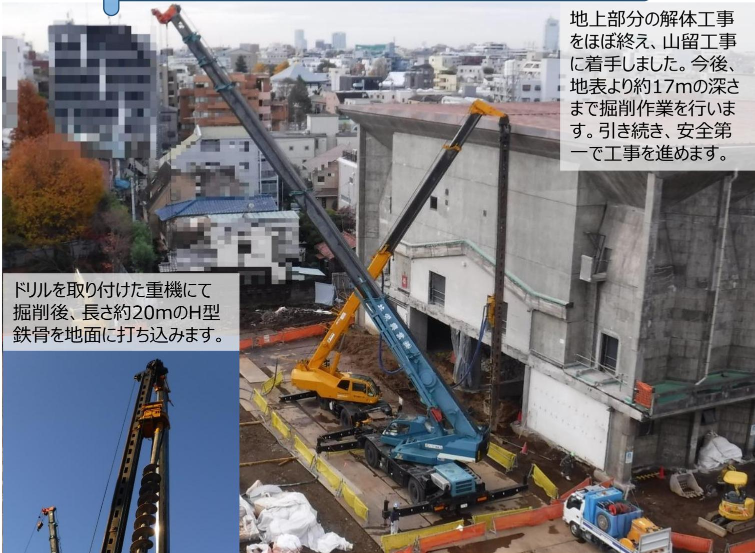
山留工事とは、掘削作業を行う際、周辺地盤への影響を防ぐ為の土留工作物（H型の鉄骨等）を設置する工事です。
