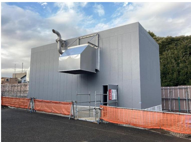
1期工事中は、仮設の非常用発電機を設置します。工事期間中に震災等が発生した場合でも、仮設の非常用発電機が稼働し、本庁舎の災害対策機能は確保されます。
