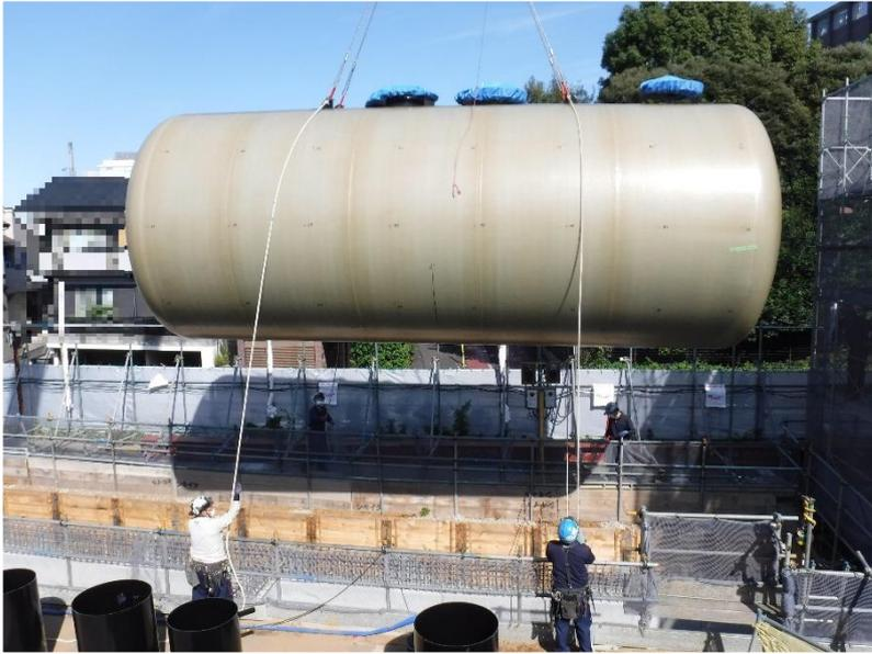
西敷地では、オイルタンクを納める地下躯体の構築後に、直径3.2m、全長8.5mのオイルタンク本体の設置を行いました。（写真上・右）
