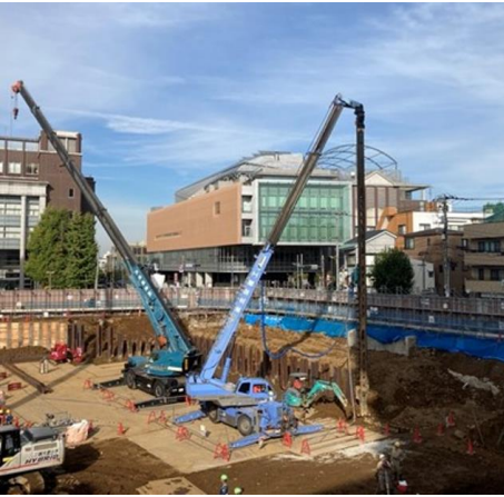
①山留工事
