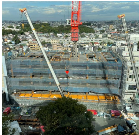
④鉄骨工事
