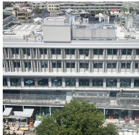
⑤内外装仕上工事
