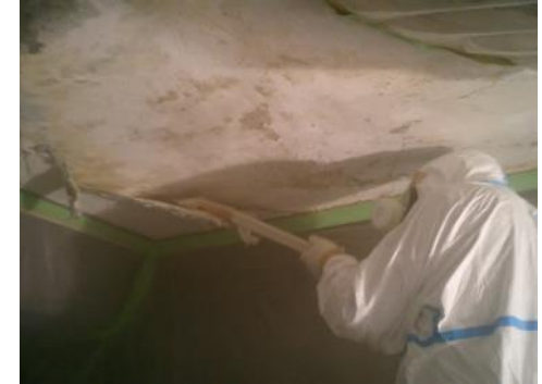
6.除去作業状況
