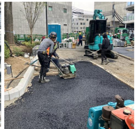
⑥外構工事
