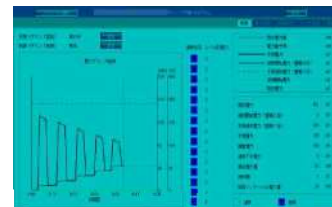
デマンド監視画面 他施設運用事例
