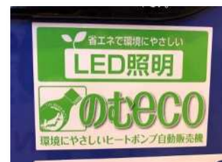
ヒートポンプ自動販売機の設置
