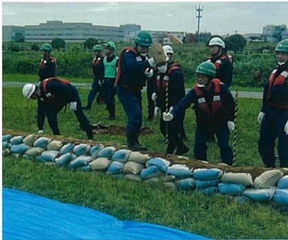
積み土のう工法
