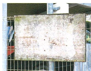
掲示板修繕前
