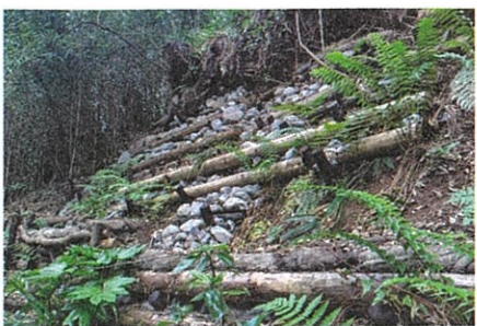
斜面に土留めを設置し、土砂の流出を防止する工夫をしました。
