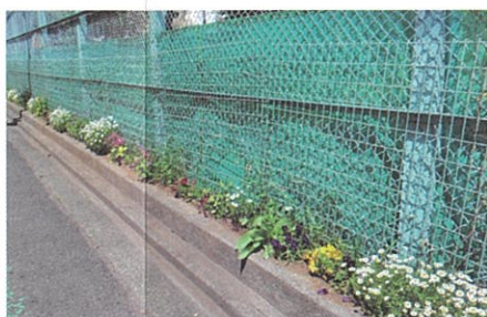
尾山台小学校南側フェンス沿い
