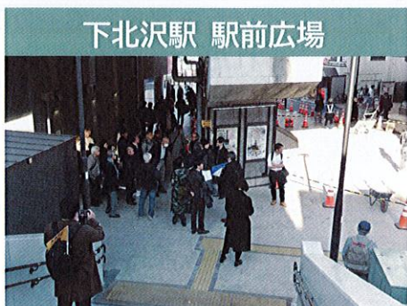
整備が進む駅前広場
