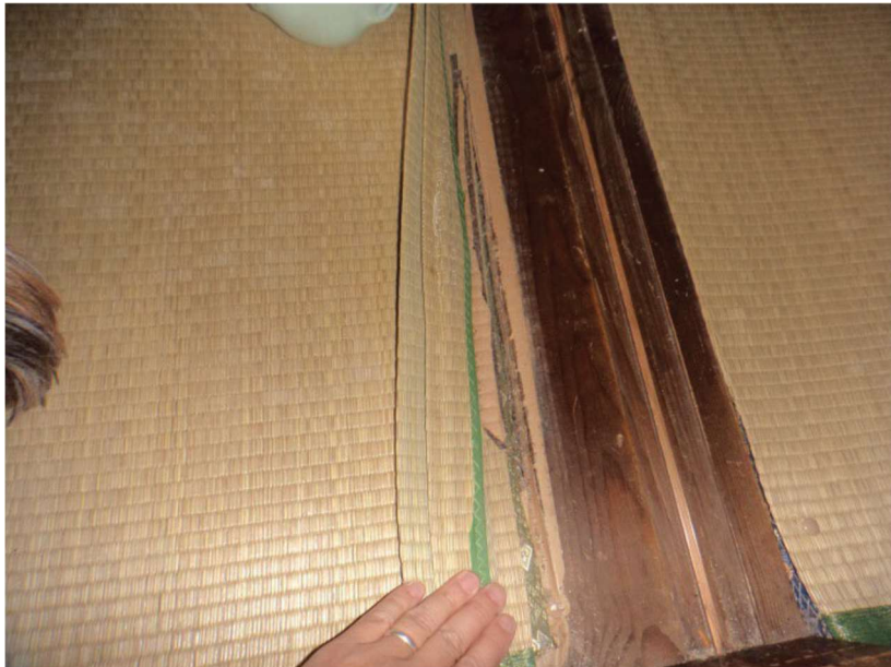
提供：長野県大町市（平成26年神城断層地震の際に市職員が撮影）
