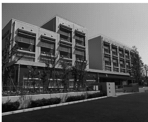
図 3 (a) 太陽光発電を設置した区施設
