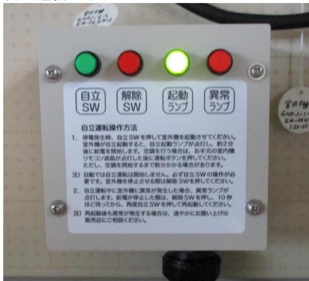
2. 空調を使用する場合は、**操作盤内の室内機リモコン液晶**が点灯した後に運転ボタンを操作する。但し、空調が稼動するまでに数分かかる場合がある。
