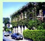
深沢環境共生住宅
