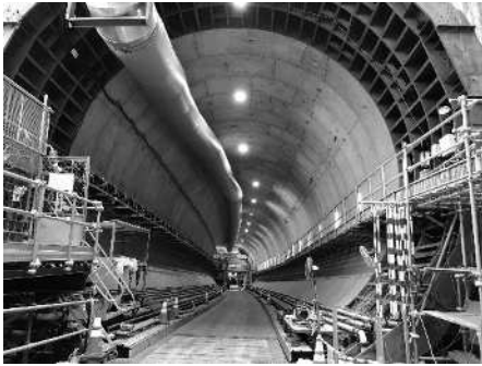
Hランプ坑口
