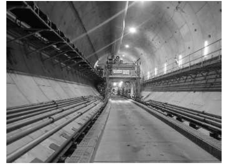
Hランプ坑内（シールド先端部）
