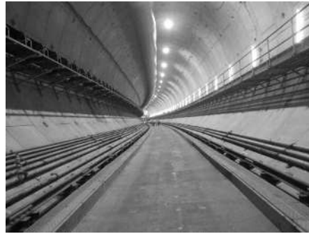
Hランプ坑内（シールド構築状況）
