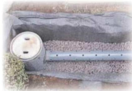
雨水浸透管・浸透ます
