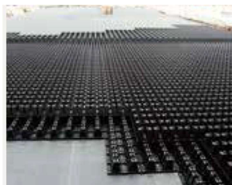
左：地下浸透貯留施設（出典：（株）クロスウェーブ HP）
