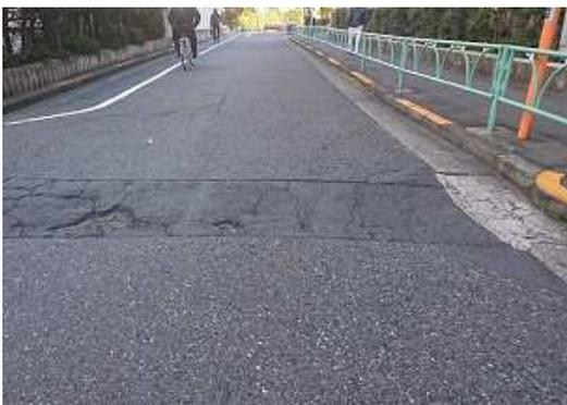
復旧工事箇所は転圧不足により沈下し、既設舗装との継目には段差が発生
