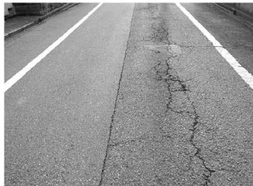
復旧工事が行われない右半面の舗装は劣化・損傷している
