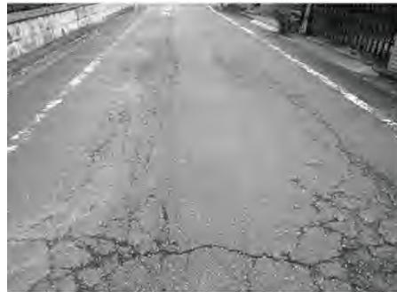
舗装厚の不足により、車輪通過部に亀甲状のひび割れが発生
