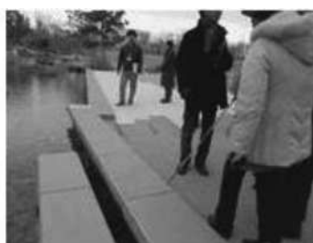
▲竣工後の池の端の確認
