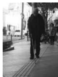
誘導用ブロックの敷設確認の様子
