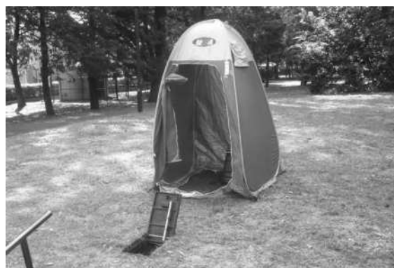
公園内のマンホールトイレ
