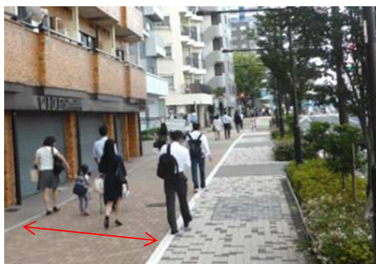
歩道有効幅員約 3.5 m
