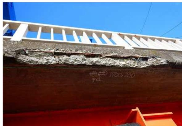
剥離・鉄筋露出（地覆）
