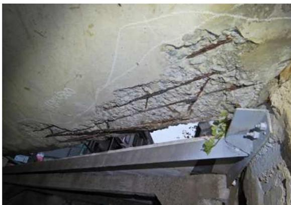
剥離・鉄筋露出（主桁）
