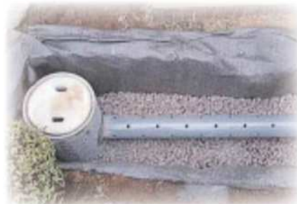
雨水浸透管・浸透ます
