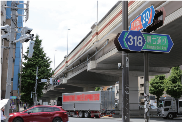
■大原交差点：「環7」と甲州街道が交差し、その上を首都高速4号線が跨ぐ（トラックの向うは「環7」をくぐる甲州街道のアンダーパスが・・・。） 撮影：令和8年5月。
