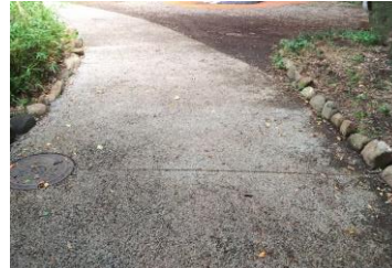
透水性舗装(岡本公園)
