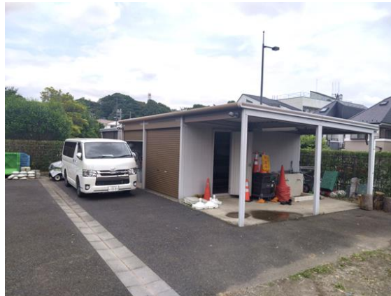
公園管理施設(二子玉川公園)
