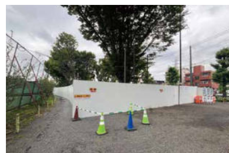
仮設事務所・仮設トイレ整備工事がケヤキ並木で始まりました。
