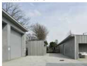
バックヤード・防災倉庫
