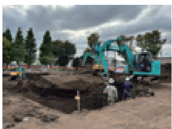
既開園区域 令和6年度改修工事の様子
